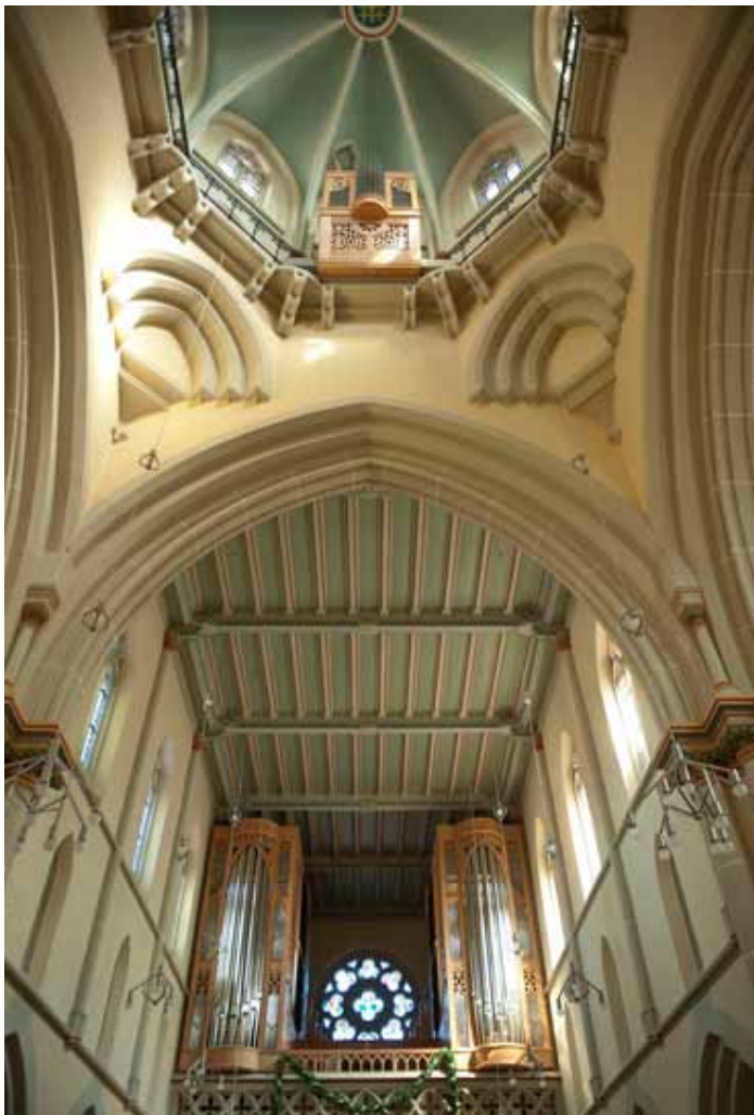
Im schrägen Blick nach oben: Haupt- und Fernwerk auf einen Blick.
